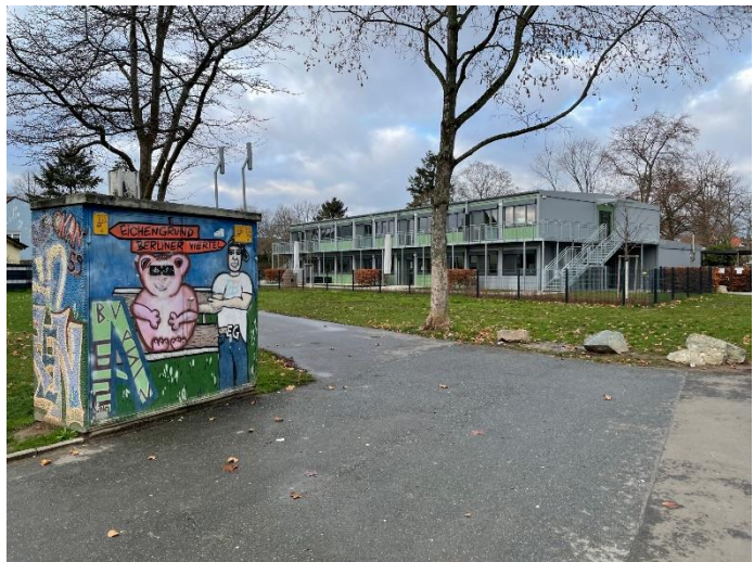
Container Kita auf dem Gelände der Danziger Anlage. Ein Provisorium für fünf Jahre für 2,6 Millionen Euro.
