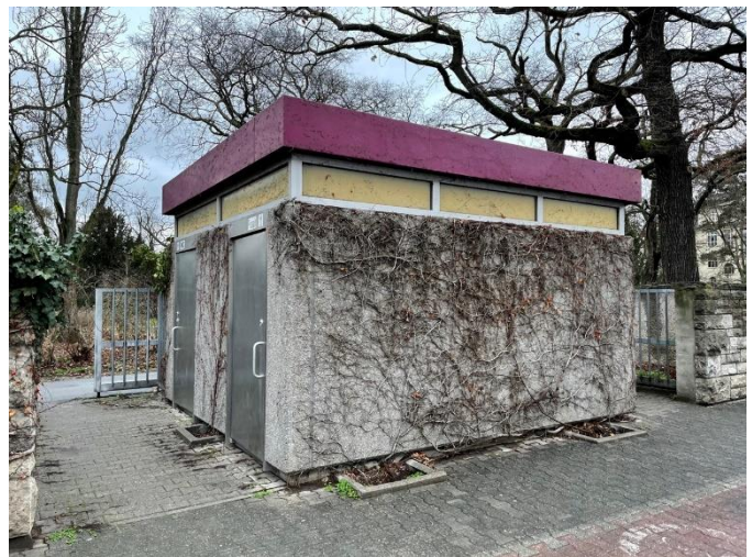
Dieses Klohäuschen möchte Baudezernent Nils Kraft für 350.000 Euro „denkmalgerecht erneuern“.
