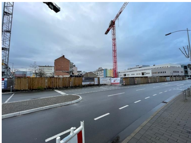
Neubau auf dem Areal des ehemaligen Karstadt-Geländes. Allein der Abriss würde fast doppelt so teuer, wie geplant.
